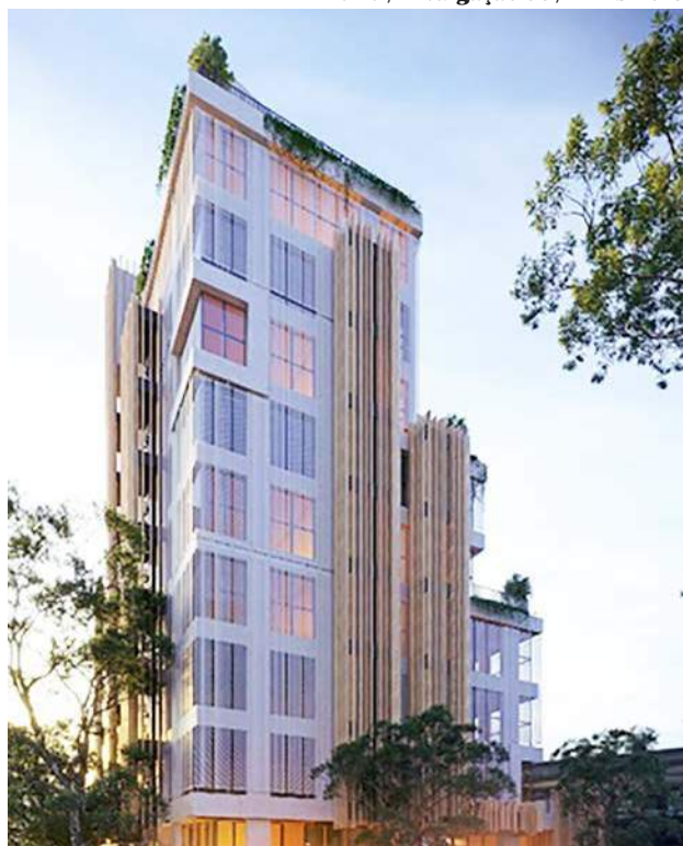
O hotel na zona sul de BH será o primeiro da marca Tribe na América do Sul
