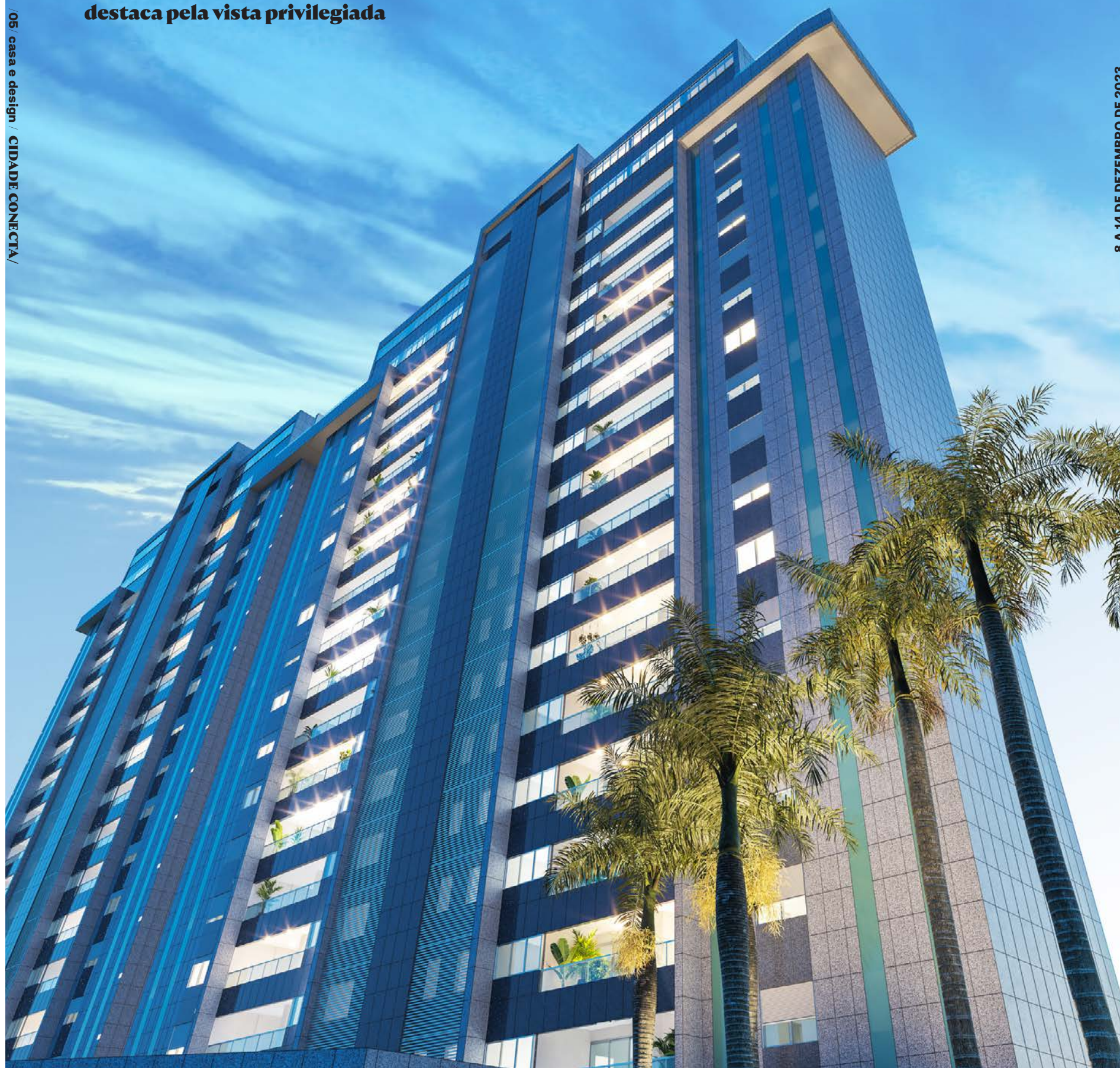
Fachada do Zenith Residence: revestimento em granito que proporciona maior beleza arquitetônica e conforto interno térmico e acústico
