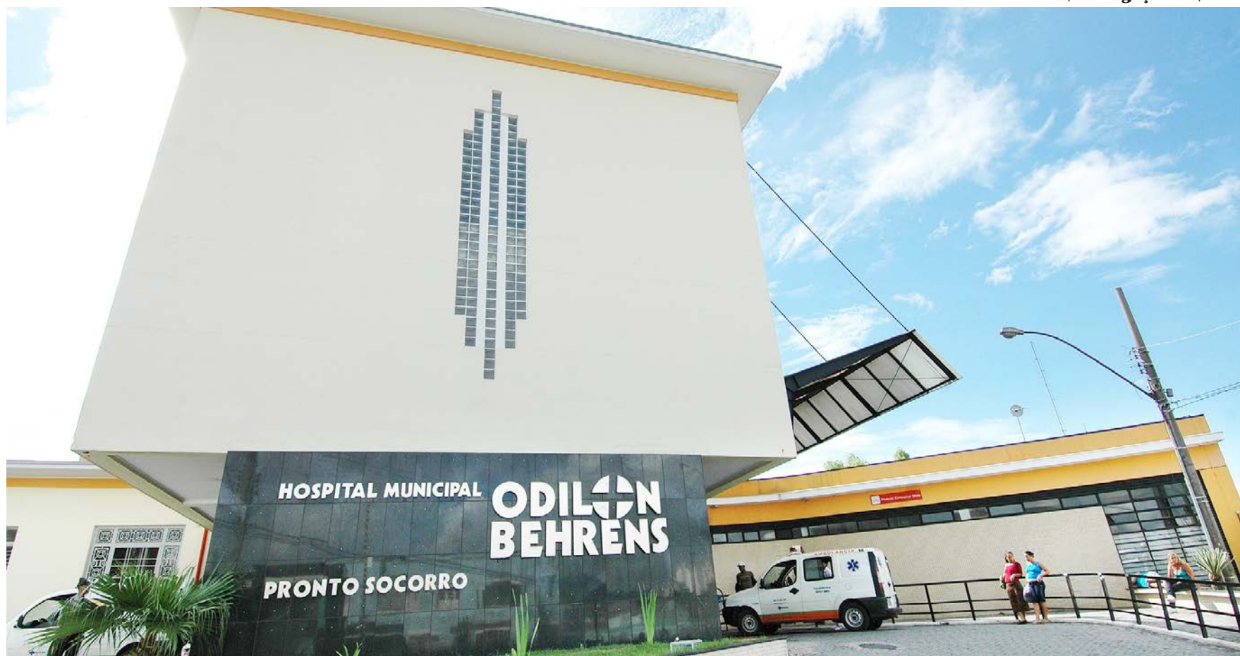
O prédio do Hospital Metropolitano Odilon Behrens é tombado pelo Patrimônio Histórico e tem projeto arquitetônico concebido no estilo Art Déco
