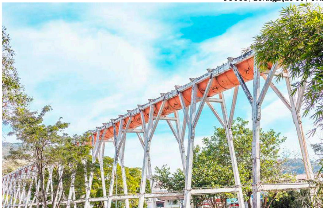
Construído em 1890, o Bicame será reformado em sua estrutura e terá outras ações como aplicação de pintura nova
