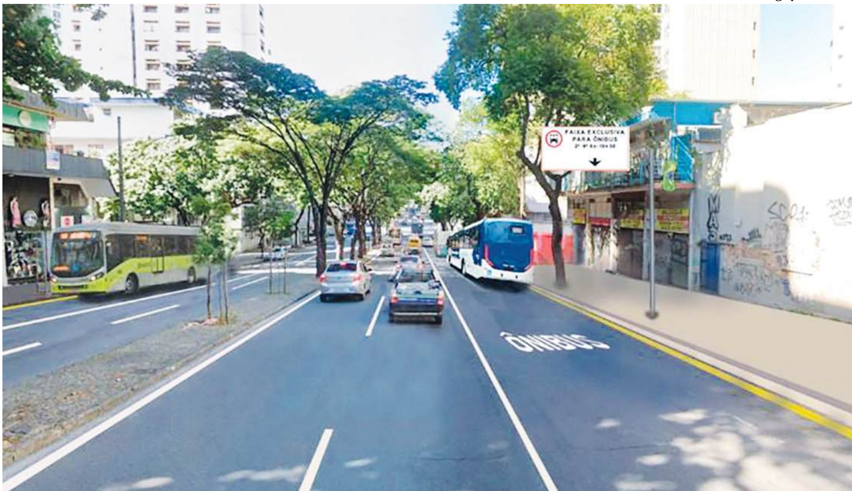
As obras fazem parte do contrato de financiamento com a Caixa Econômica Federal, no valor de R$ 139,4 milhões
