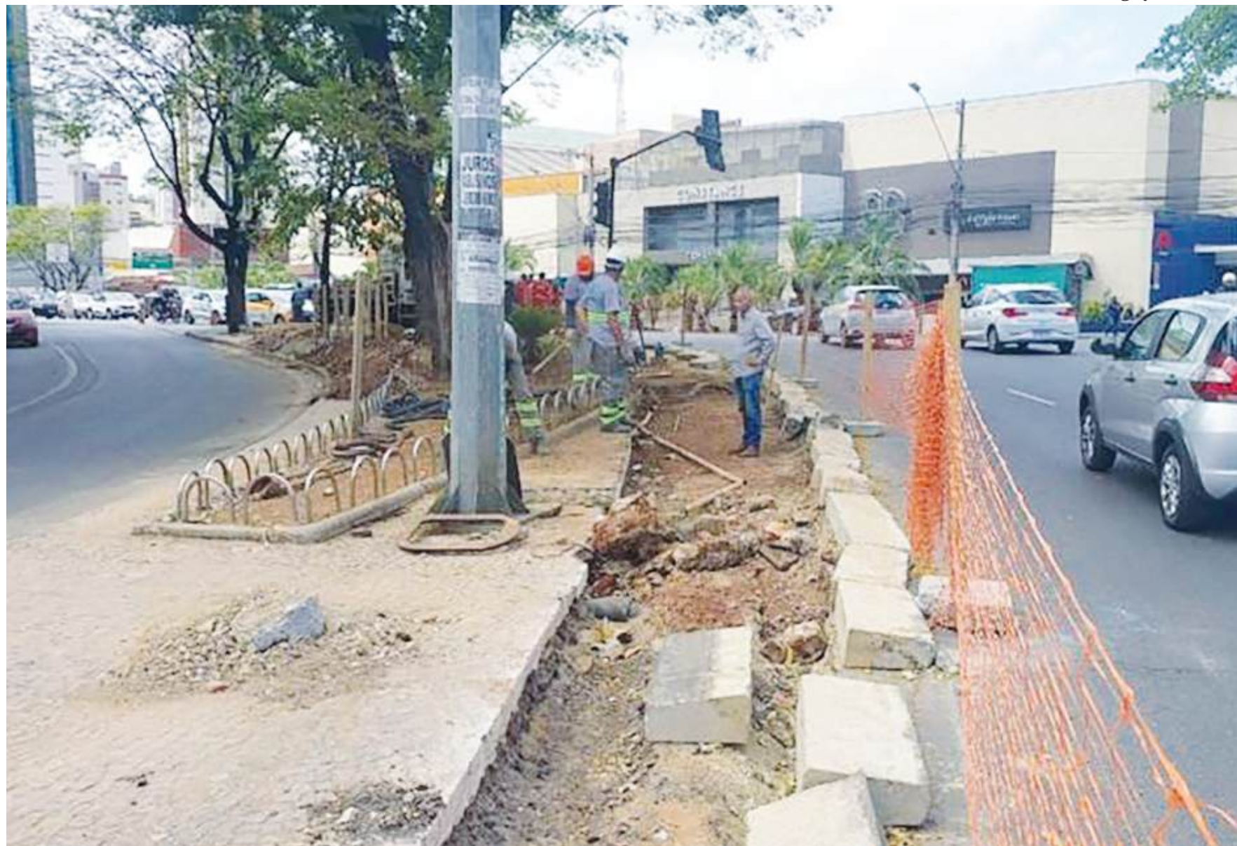
Obras de implantação das faixas exclusivas das avenidas Cristóvão Colombo e João Pinheiro, na Savassi
