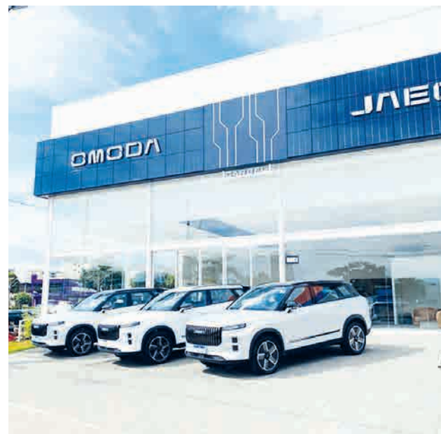
Nova concessionária da O&J fica em avenida importante de Uberlândia
