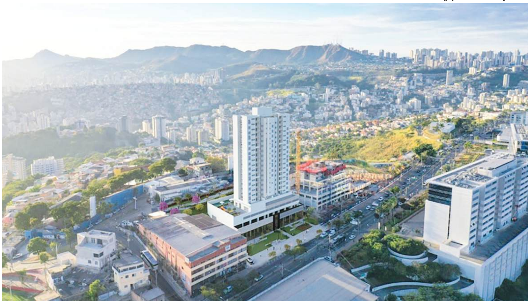
Novo residencial da Riva Incorporadora será erguido na avenida Raja Gabaglia
